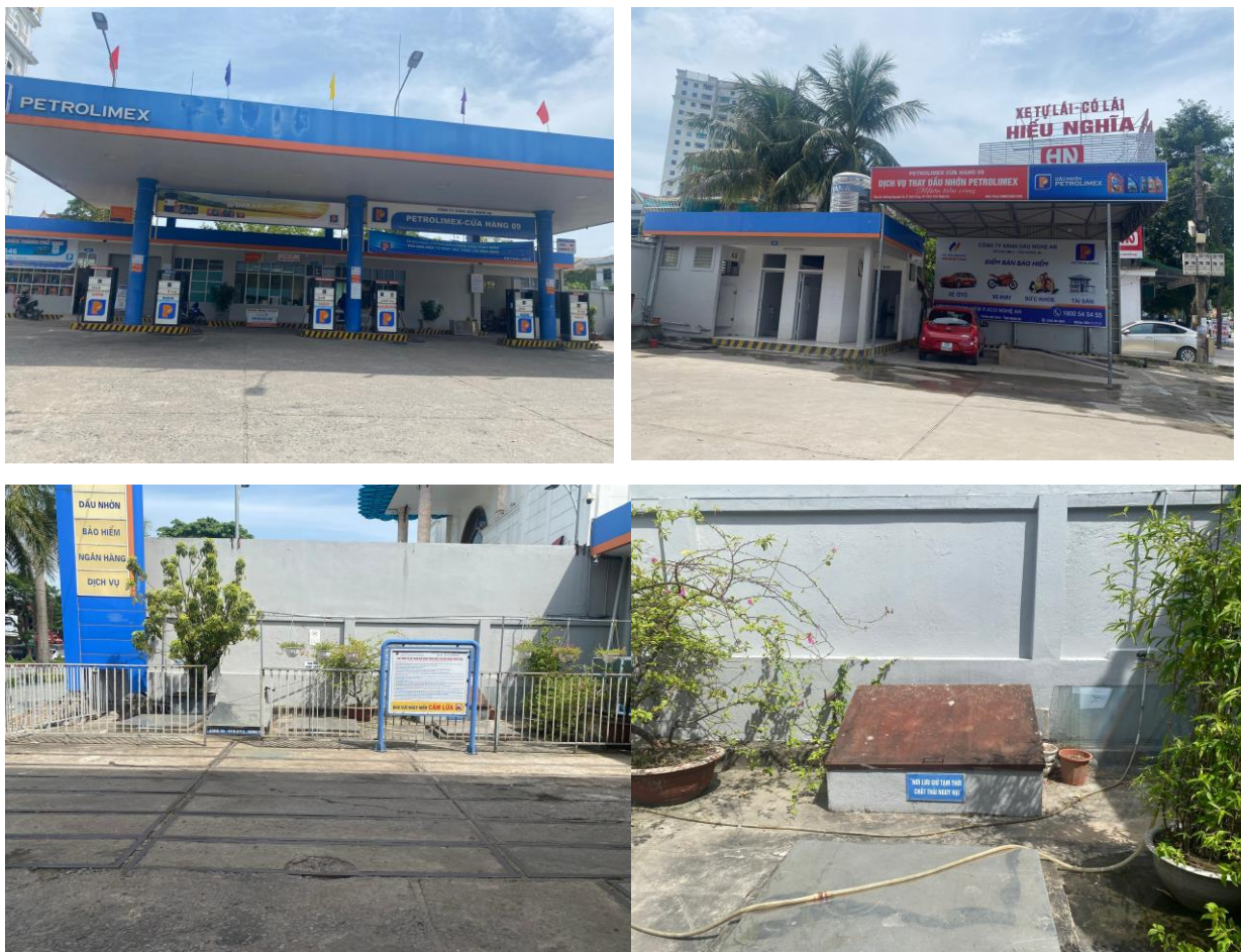
Hình 1.2. Hình ảnh hiện trạng dự án
