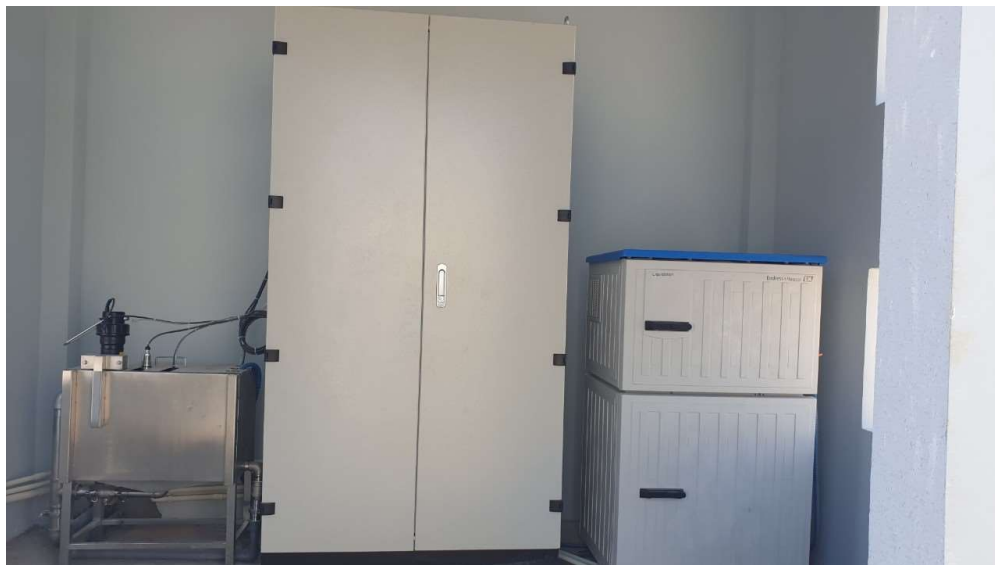
Hình 3.9. Tủ quan trắc nước thải online
