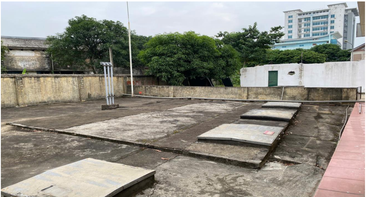
Hình 1.2. Bể chứa chôn ngầm bằng hệ thống nhập kín
