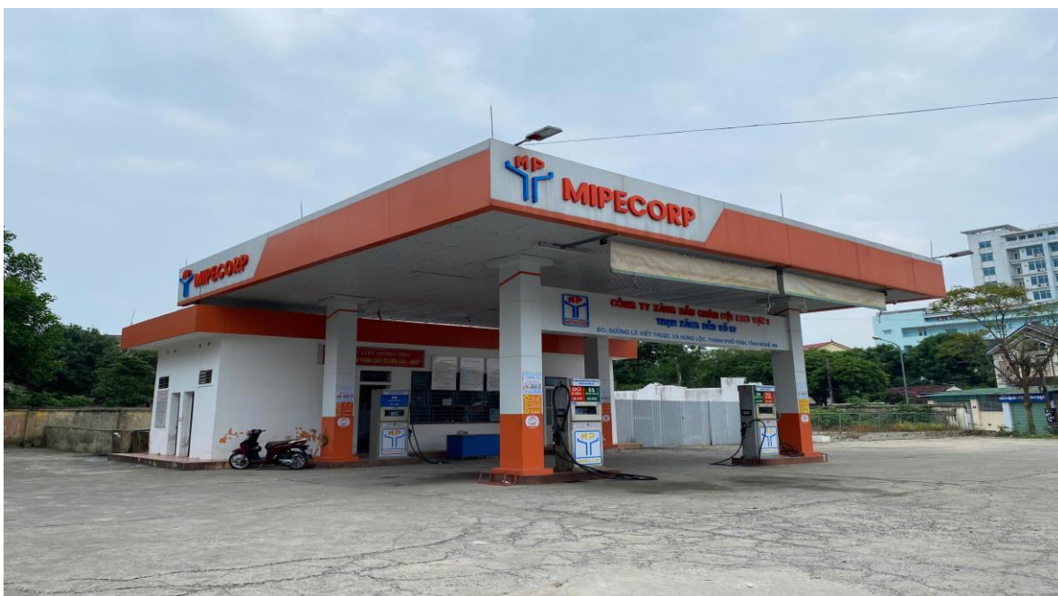
Hình 1.5. Trạm xăng dầu số 37
