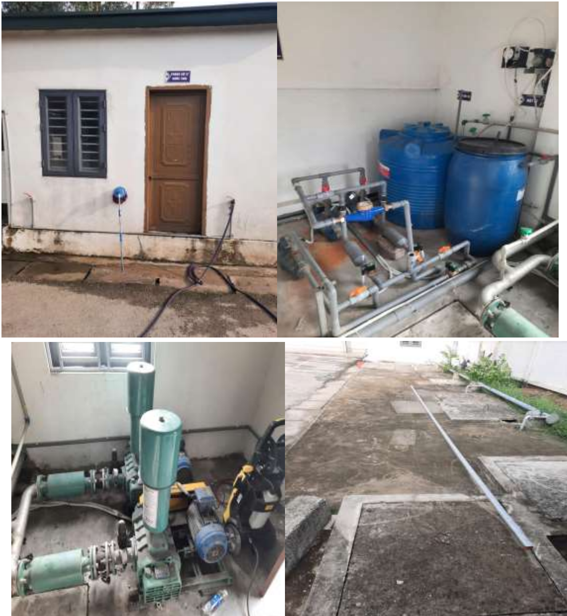
Hình 3.5. Hình ảnh hệ thống xử lý nước thải tập trung của cơ sở
